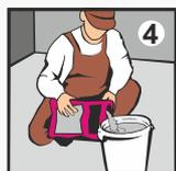
**4** Для приготовления раствора залейте водопроводную воду комнатной температуры в чистую ёмкость из расчёта 4,0-4,5 л на один мешок (25 кг). Засыпая сухую смесь в воду, перемешивайте раствор дрелью со специальной насадкой на низких оборотах до получения однородной массы. Подождите 3-5 минут, после чего перемешайте повторно. Время пригодности раствора к работе не менее 2-х часов.
